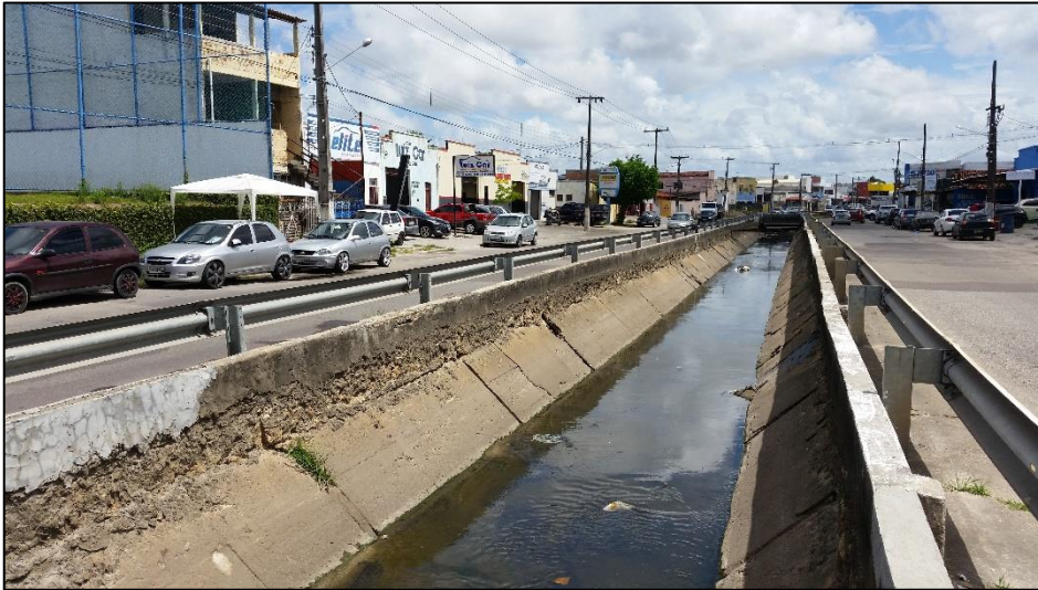
Figura 9 - Canal da Avenida Dr. Airton Teles
