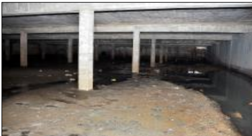
Figura 23 - Reservatório subterrâneo implantado em praça de Porto Alegre-RS
