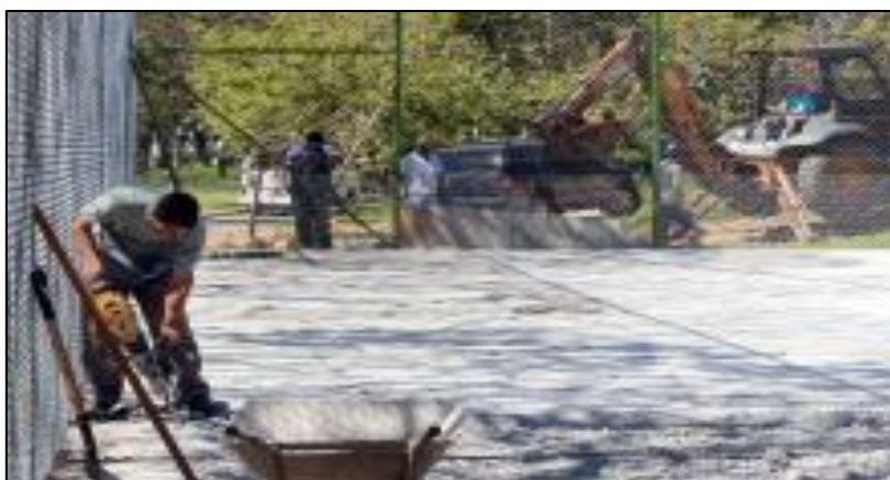
Figura 24 - Quadra poliesportiva localizada sobre o reservatório de detenção
